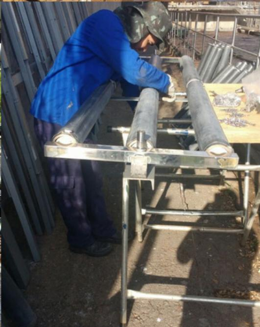
É comum que, conforme o tempo de operação do sistema por ar difuso se prolonga, pode ocorrer depósitos na membrana dos difusores, dificultando a passagem do ar e fazendo aumentar a pressão do ar no interior da membrana. Se muito elevada, essa pressão diminui a vida útil das membranas do sistema, o que pode acarretar em menor eficiência de operação e diminuição da vida útil de operação de todo o sistema, além de maior consumo de energia elétrica.
