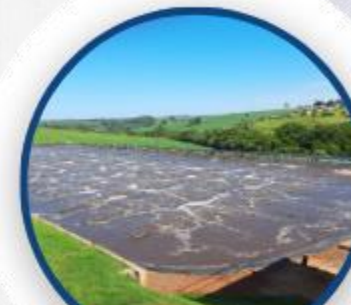
SISTEMA DE AERAÇÃO
