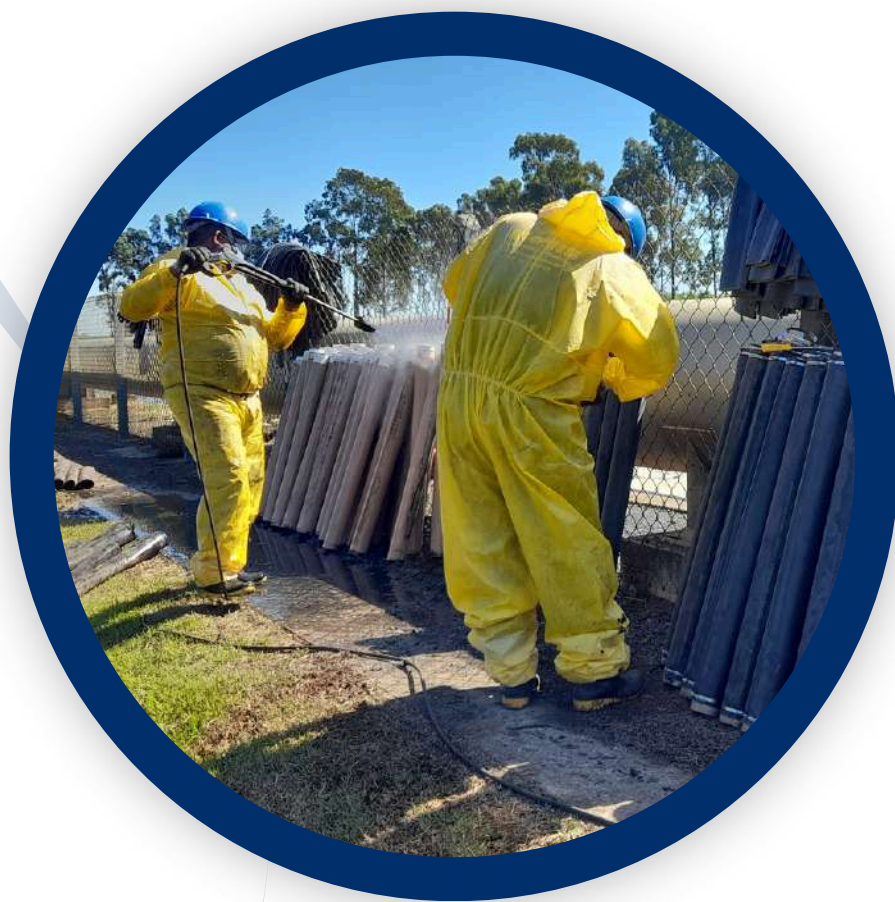
Contrato de Manutenção Preventiva ou Corretiva
